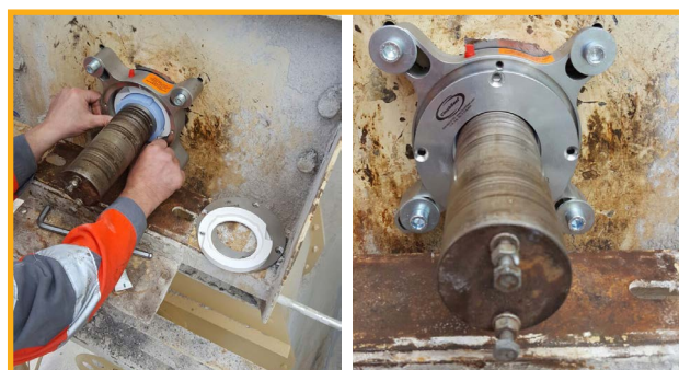
Segundo RotorCup y tapa de la carcasa instalados.
