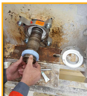
RotorCup y RubberBoot instalados.
