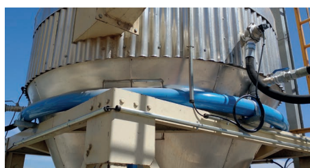
AirSweep instalado en la parte exterior.
