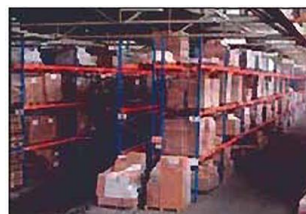
Protección de almacenes.
